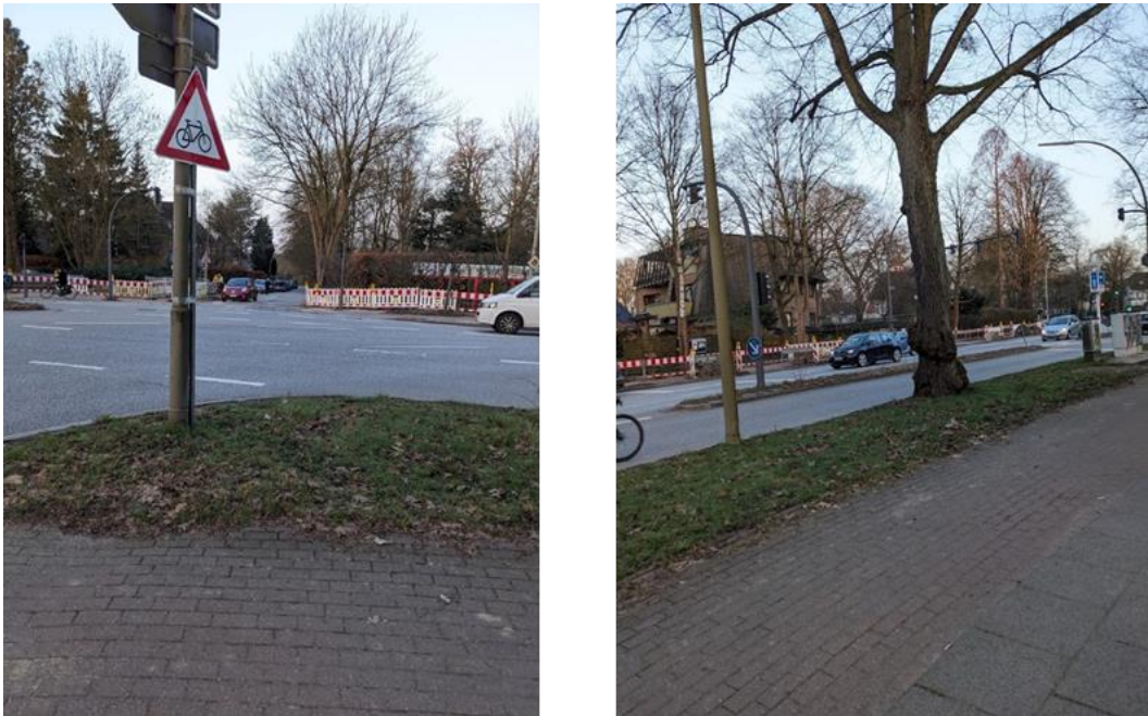
Abbildung 2: Baustelle Fuß- und Radweg Reventlowstraße Richtung Süden
