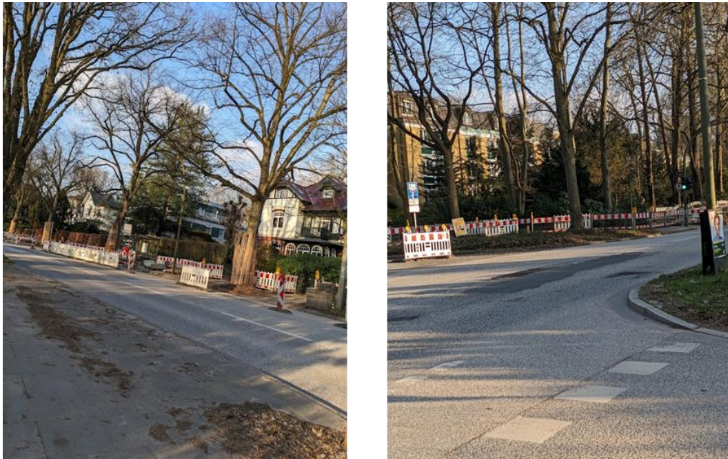
Abbildung 12: Baustelle Gehweg Reventlowstraße und Bushaltestelle
