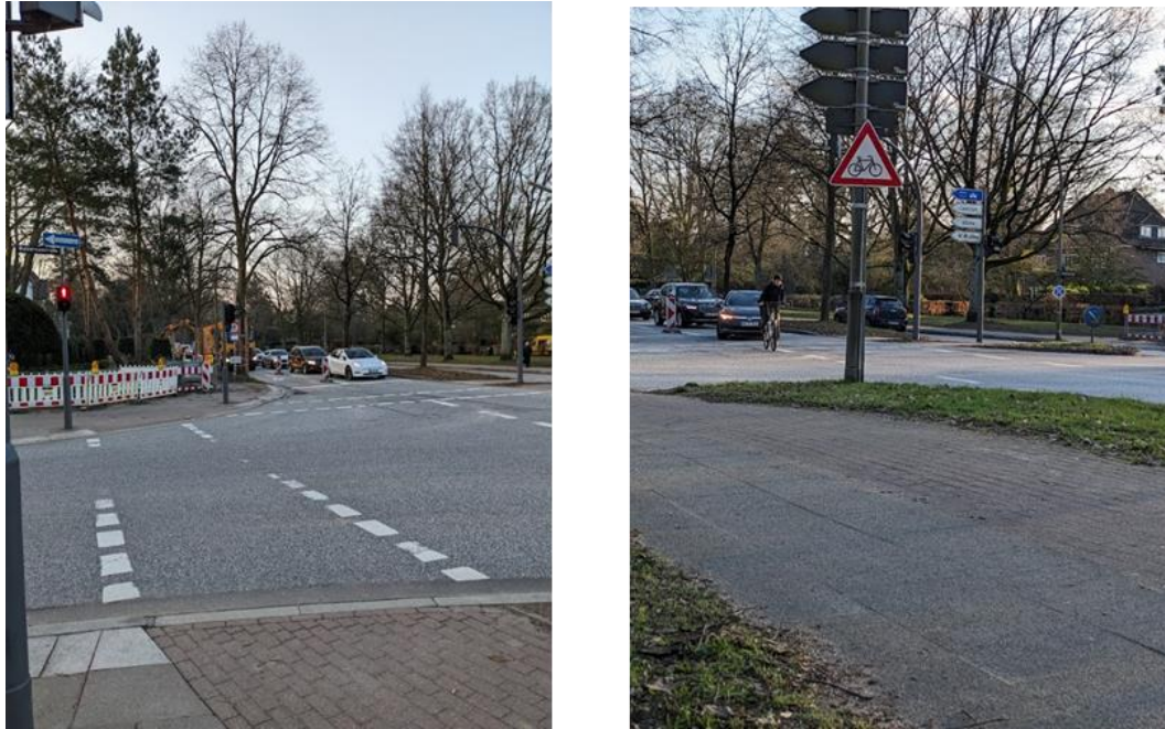
Abbildung 3: Baustelle rechte Spur (Rechtsabbieger) Reventlowstraße Richtung Norden
