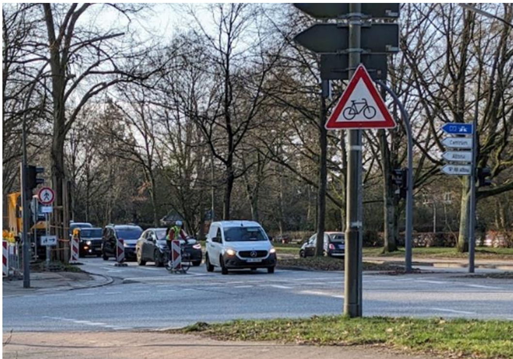
Abbildung 9: Radfahrende fahren aus Baustellenbereich in den Pkw-Verkehr
